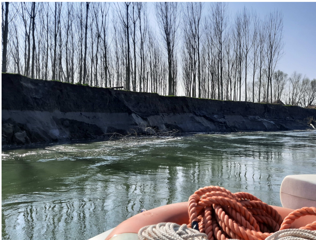
Foto 8. Fenomeni erosivi a carico della sponda del canale secondario
