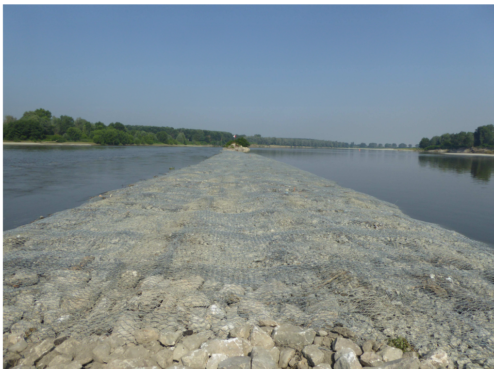
Foto 1: assetto pennello prima dell'intervento MN-E-37-NI
